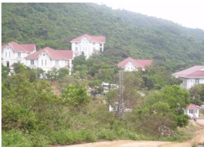
Hình 3.4: Xây dựng nhà nghỉ phục vụ du lịch tại Bãi Bắc Khu BTTN Sơn Trà
